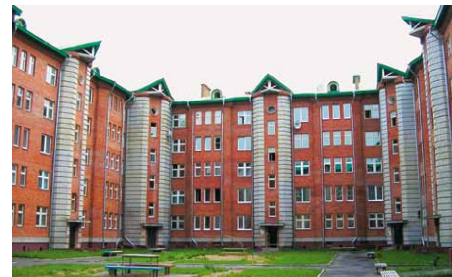
Жилой дом по ул. Орловского в Омске
