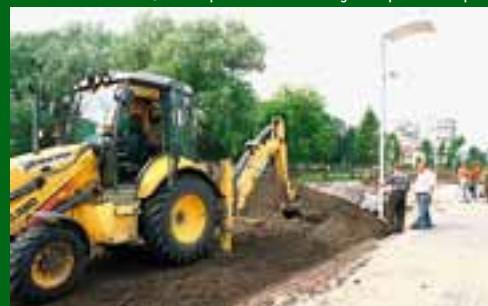
Идут работы в мкр. «Релеро»
