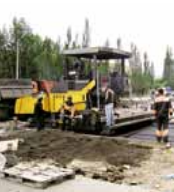
Дорожные работы при благоустройстве 12 мкр.
