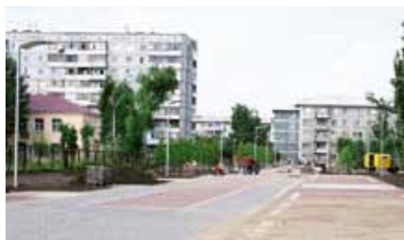
ООО «СибДор» на благоустройстве мкр. «РЕЛЕРО»
