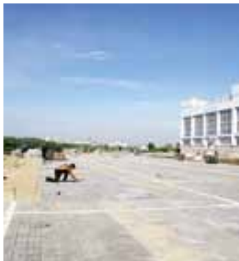
ООО «СибДор» ведет укладку плитки в культурно-историческом общественном комплексе «Омская крепость»
