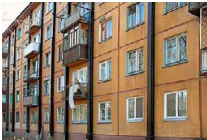
Усиление жилого дома наружными колоннами в г. Омске
