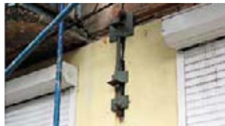
Вид анкерного устройства усиления по варианту без входа в квартиру снаружи
