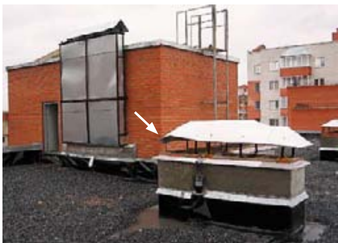
Рис. 3. Пример надстройки вентиляционных каналов, расположенных в стене лифтовой шахты
